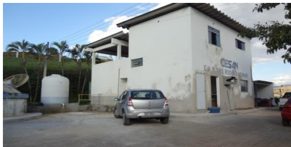
Figura 3-28 - Estação de Tratamento de Água.
